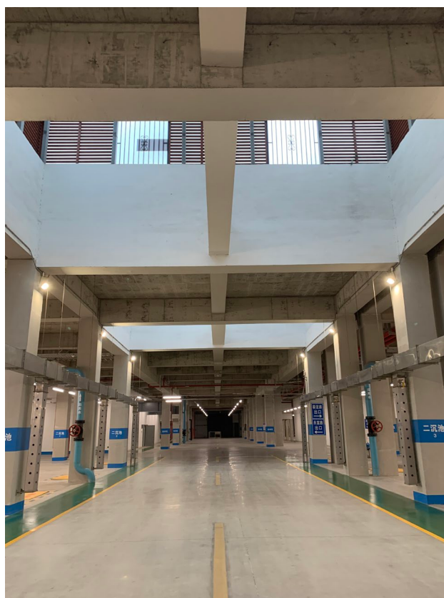
图 3 污水厂对称的建筑布局更显其宏大
