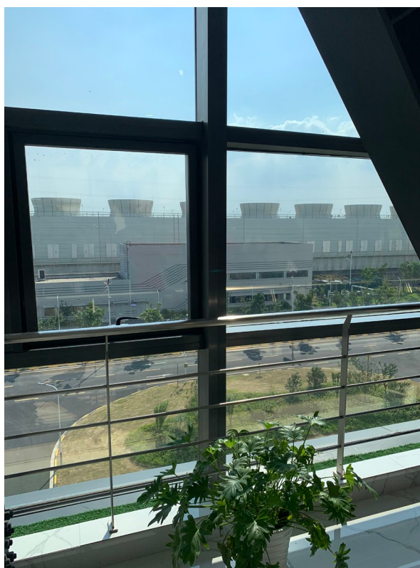
图9 窗外房顶上就是十个新型冷却塔
