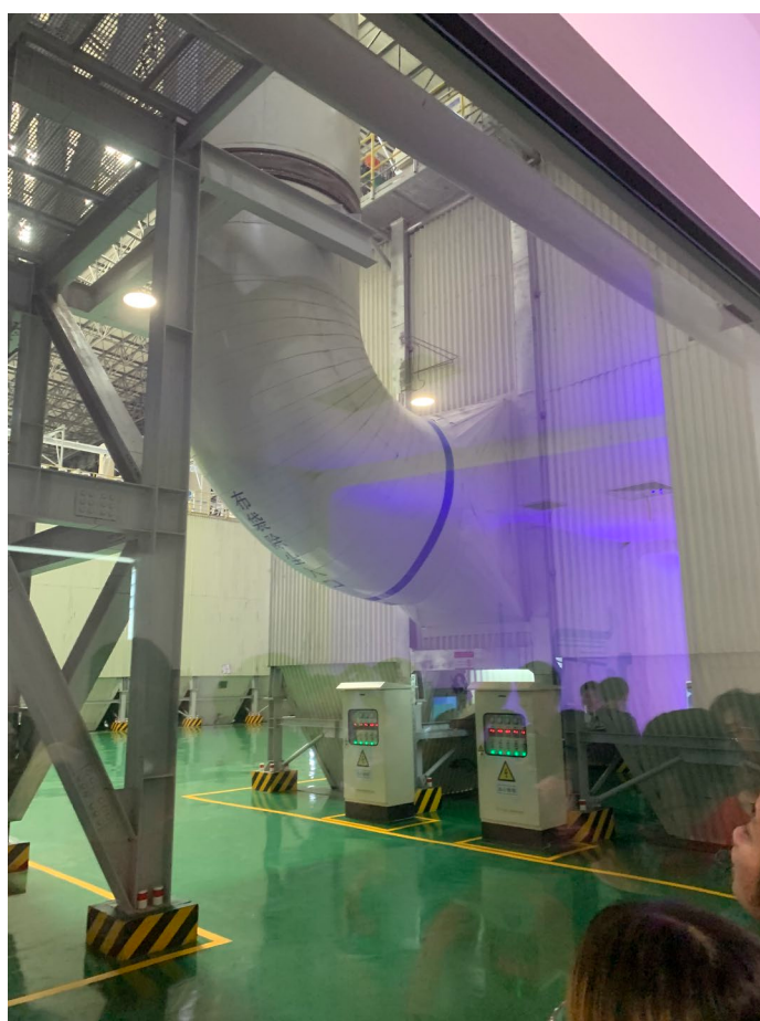
图 6 布袋除尘器（我之前没有想到实物如此庞大）
